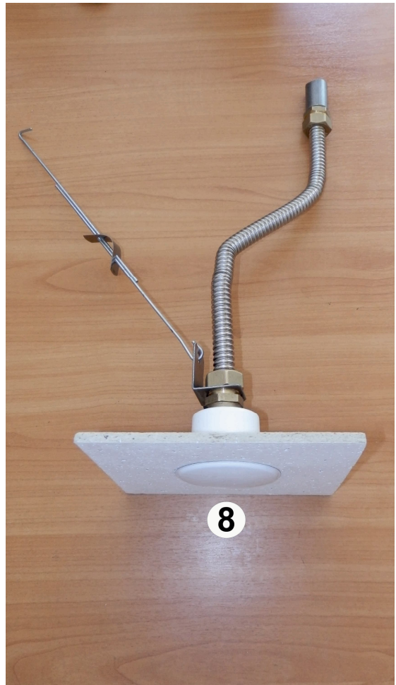
8. Установить крышку на ороситель
